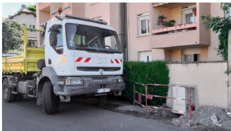
Enfouissement des réseaux en partenariat avec le SDEE.
